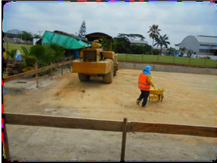
Figura N° 4.- Realización de trazados y replanteo
