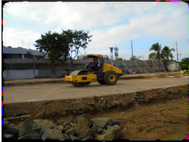
Figura N° 7.- Compactación del terreno con rodillo lizo
