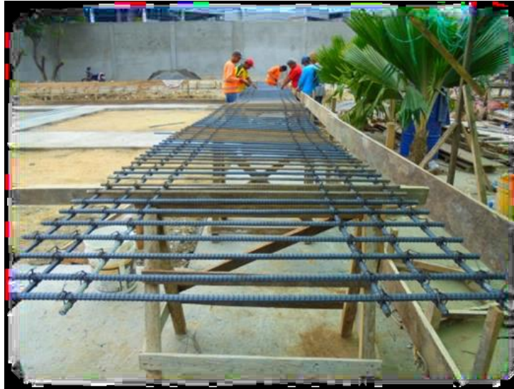
Figura N° 15.- Colocación del acero
