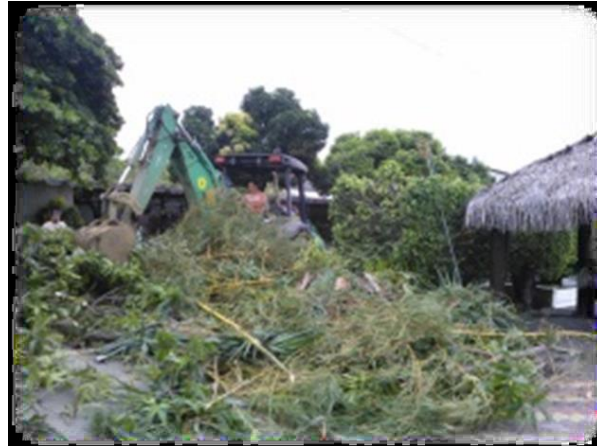
Figura N° 1.- Corte de terreno usando maquinaria
