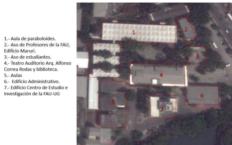
Figura N° 1.- Vista satelital de la FAU.
